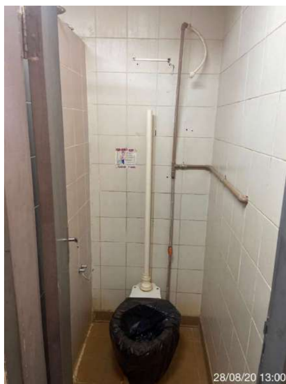
Vista banheiro de vestiário desativado
