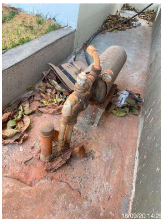
Vista Poço artesiano inativo
