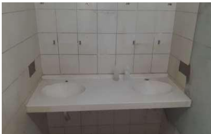
Azulejos e pia antes da reforma
