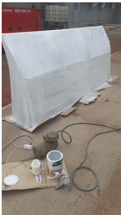
Pintura da estrutura de cobertura
