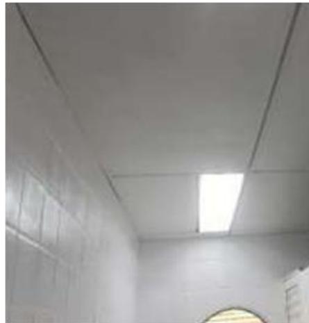
Forro do banheiro pintado 1
