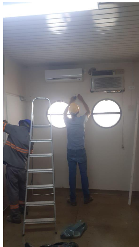
Paredes sendo lixadas para pintura
