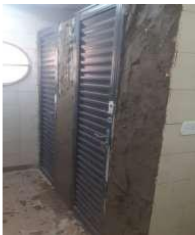
Paredes sendo rebocadas
