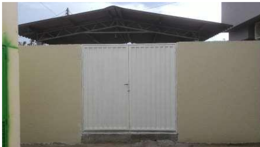
Portão instalado e pintado
