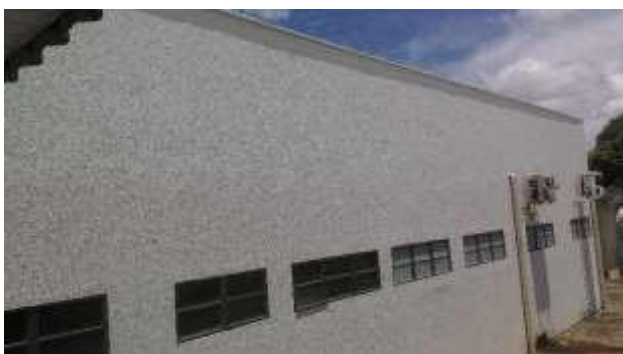
Parede parte de trás dos laboratórios pintada
