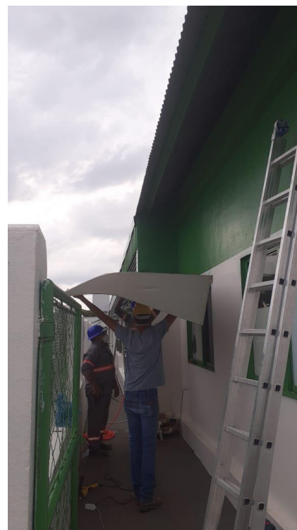
Instalação da Cobertura
