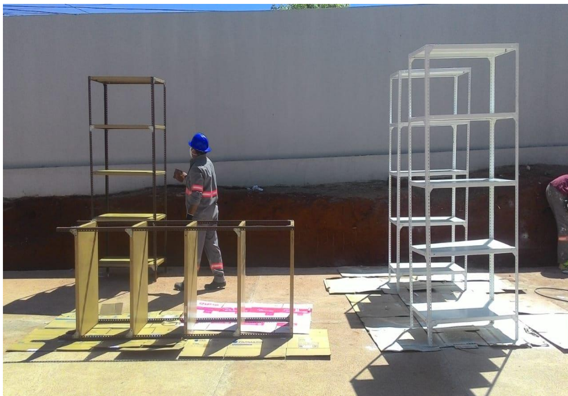
Foto. Revitalização dos armários de aço do setor de farmácia-HRSLMB.
