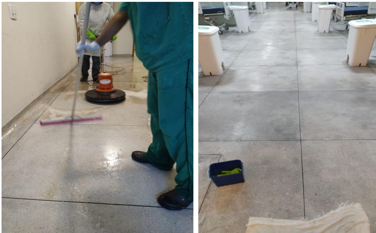
Foto 16. Iniciado tratamento do piso da unidade.
