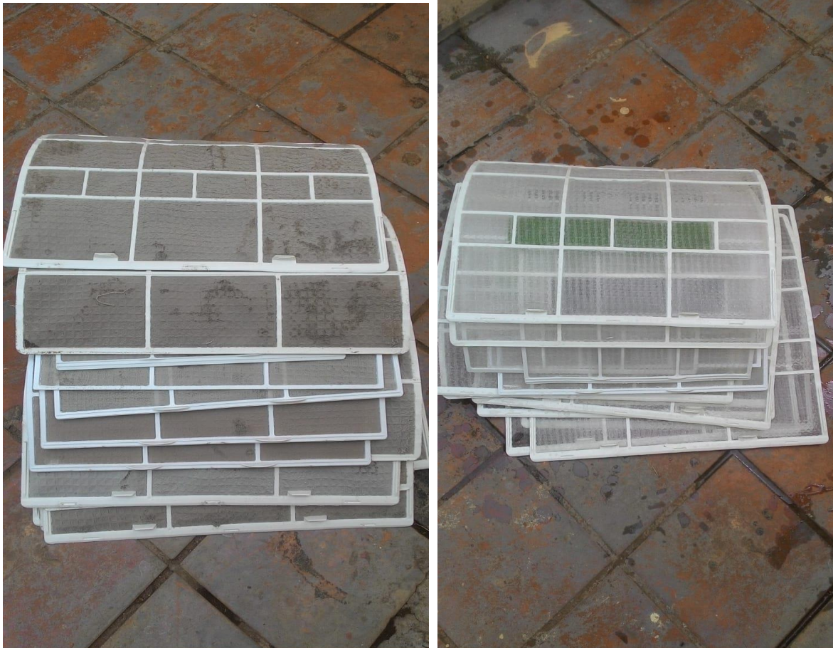
Foto 7. Higienização so filtro de ar da Unidade de Terapia Intensiva.
