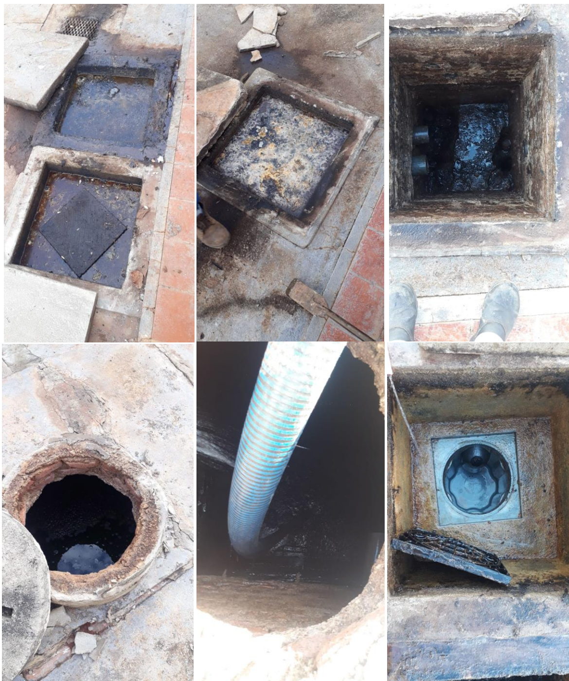
Foto 8. Higienização da sumidora da unidade e caixa de gordura.
