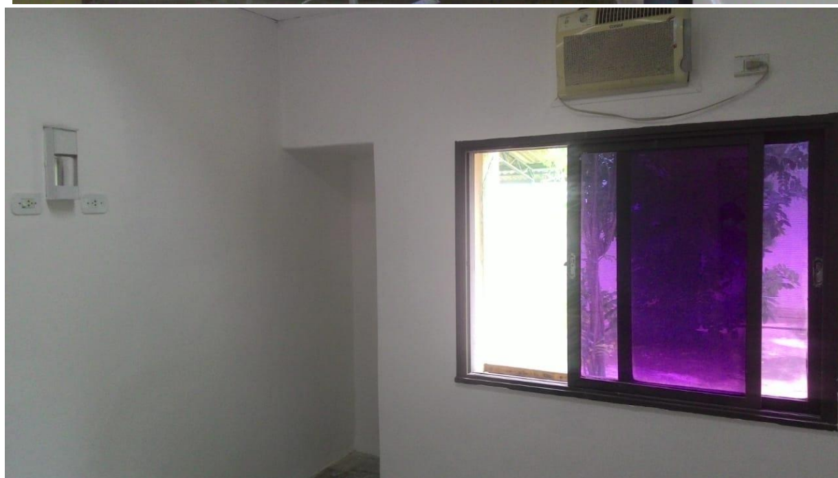
Foto 5. Paredes da sala de descanso masculino
