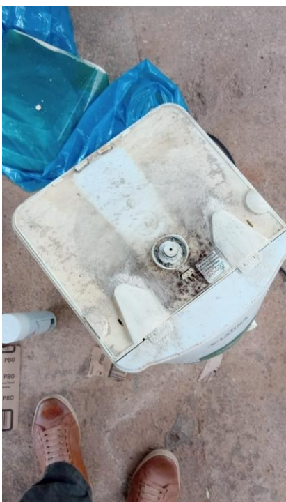
Foto 7. Higienização so filtro de ar da Unidade de Terapia Intensiva.
