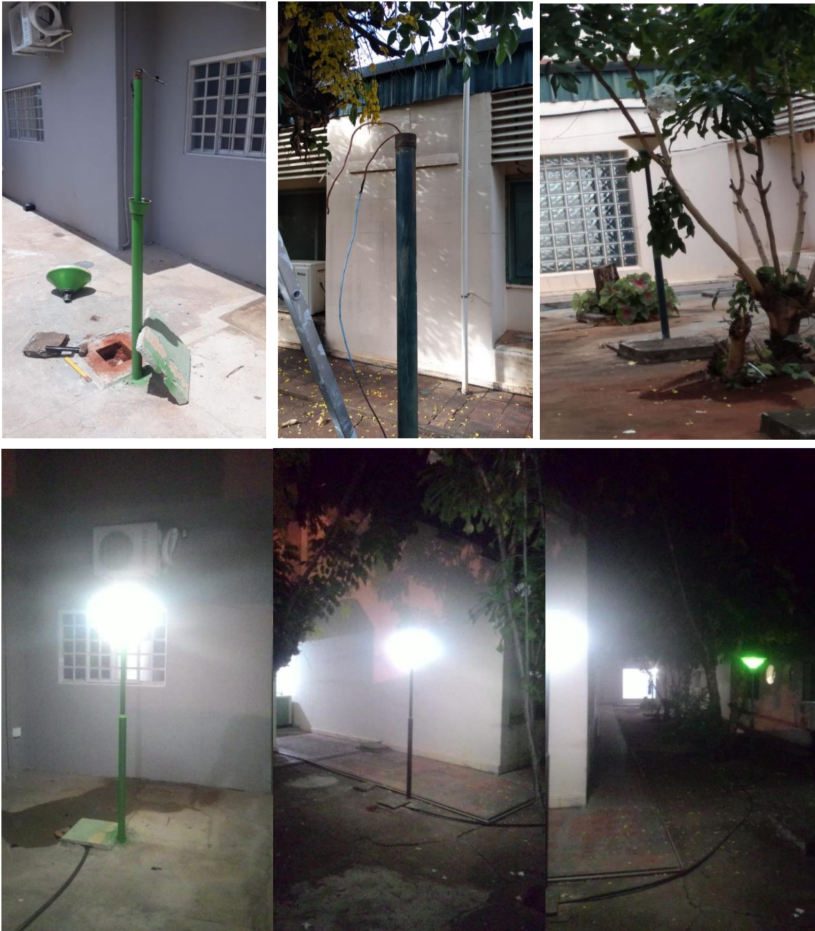
Foto 14. Manutenção das Luminárias externas.
