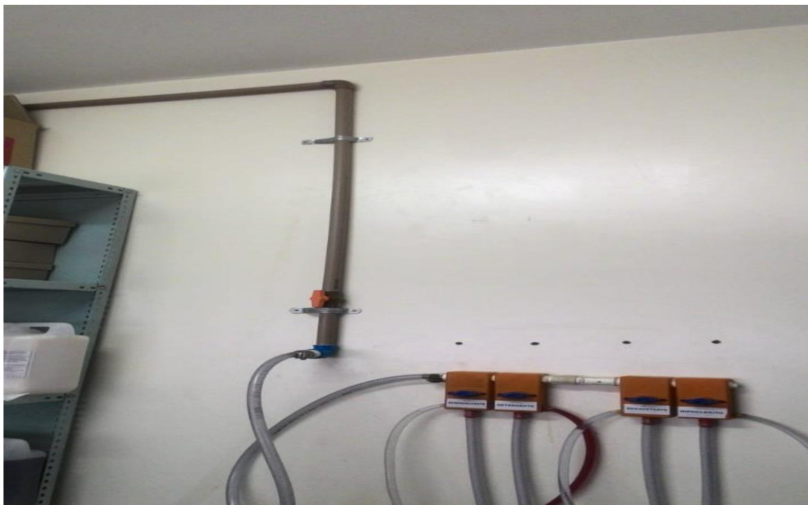
Foto 12. Instalação da tubulação de rede hidráulica para ligar os diluidores de produtos para limpeza usado pela equipe de limpeza do hospital.
