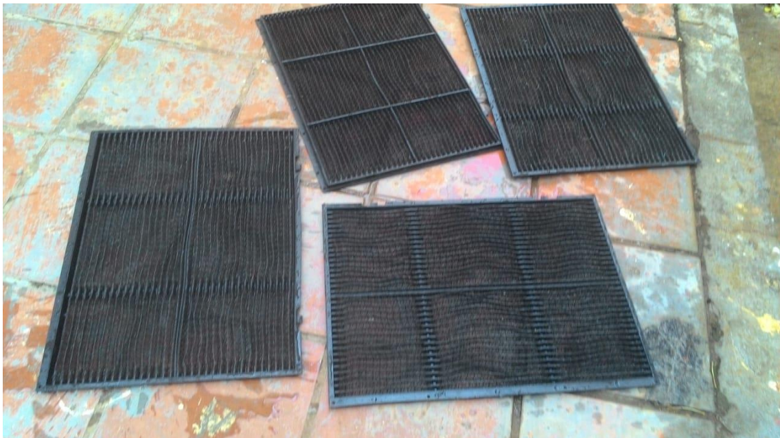
Foto 6. Higienização dos filtros de ar-condicionado.
