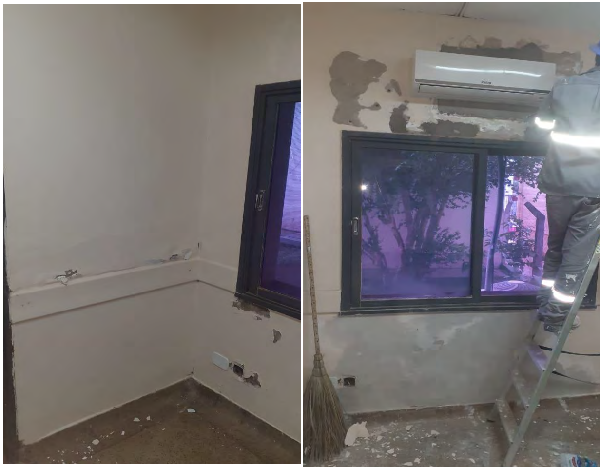
Foto. Paredes internas do banheiro feminino.
