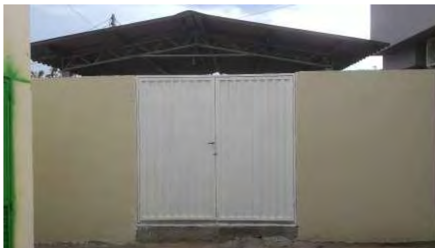
Portão instalado e pintado
