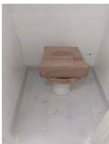
Vaso novos sendo instalados
