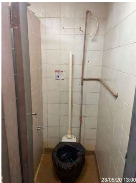
Vista banheiro de vestiário desativado
