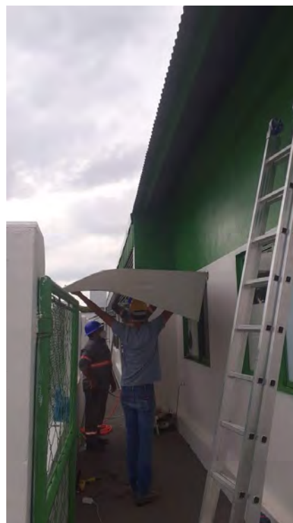
Instalação da Cobertura
