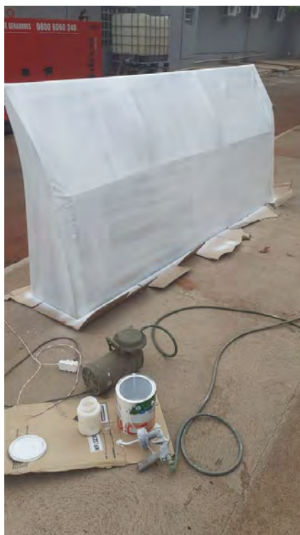
Pintura da estrutura de cobertura
