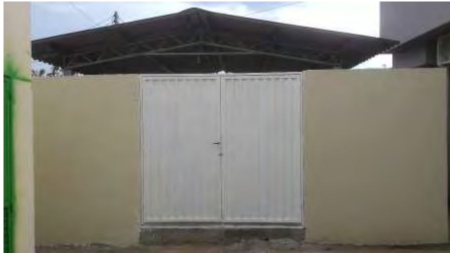
Portão instalado e pintado
