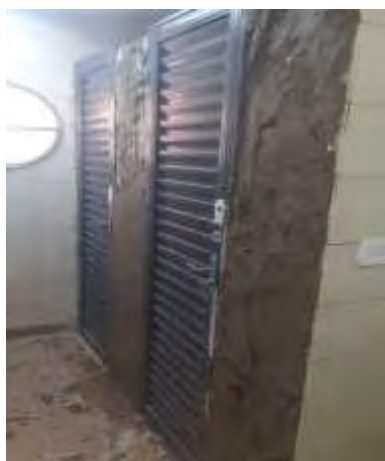
Paredes sendo rebocadas
