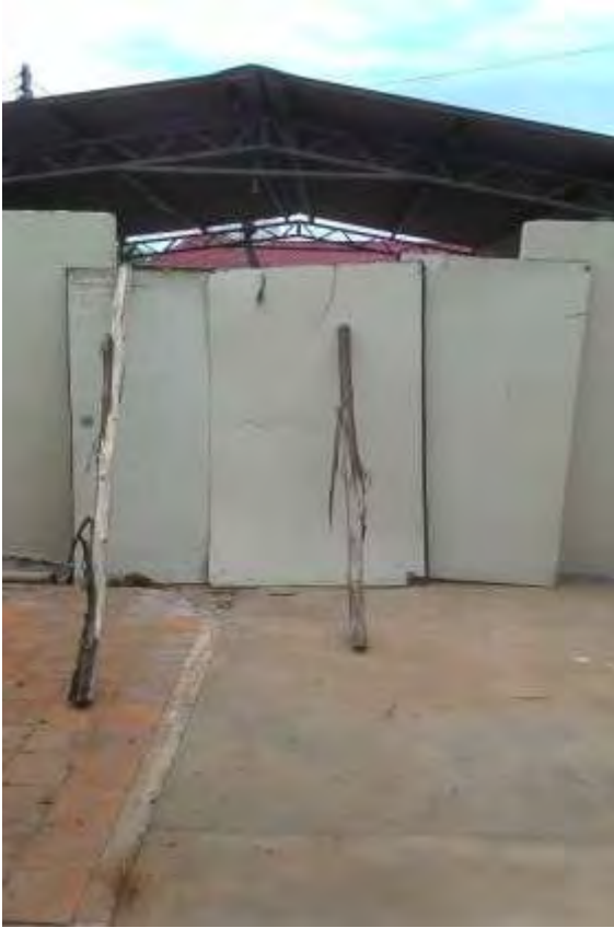
Madeiras escoradas na entrada da usina de O 2 folhas instalado
