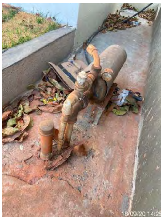
Vista Poço artesiano inativo
