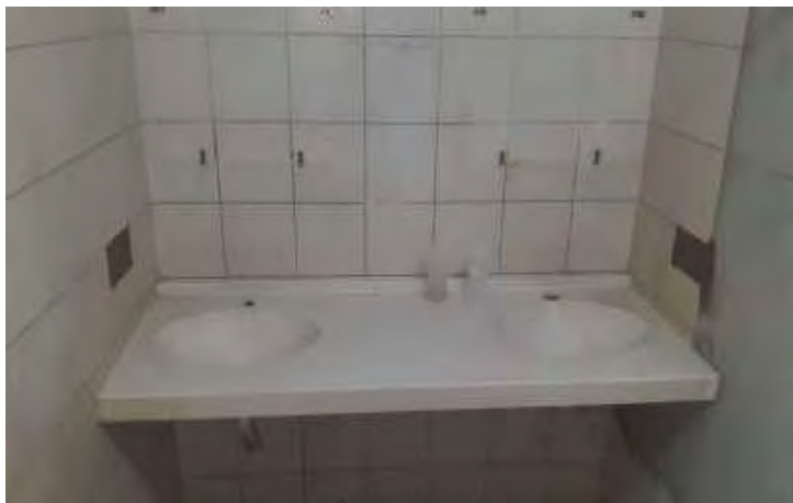
Azulejos e pia antes da reforma
