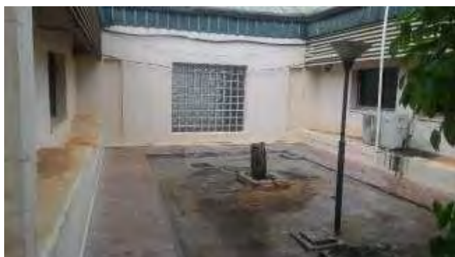
Entulhos removidos da parte externa a usina de O 2
