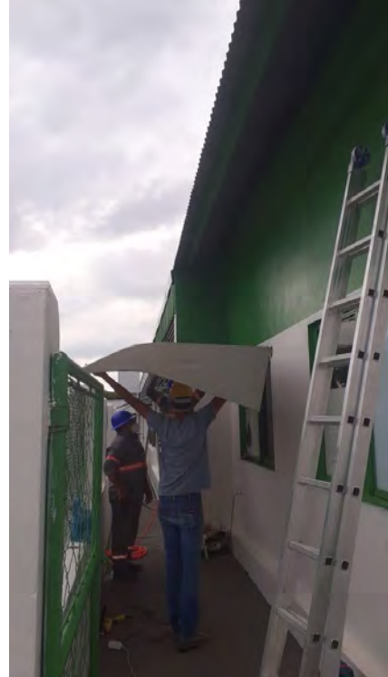
Instalação da Cobertura
