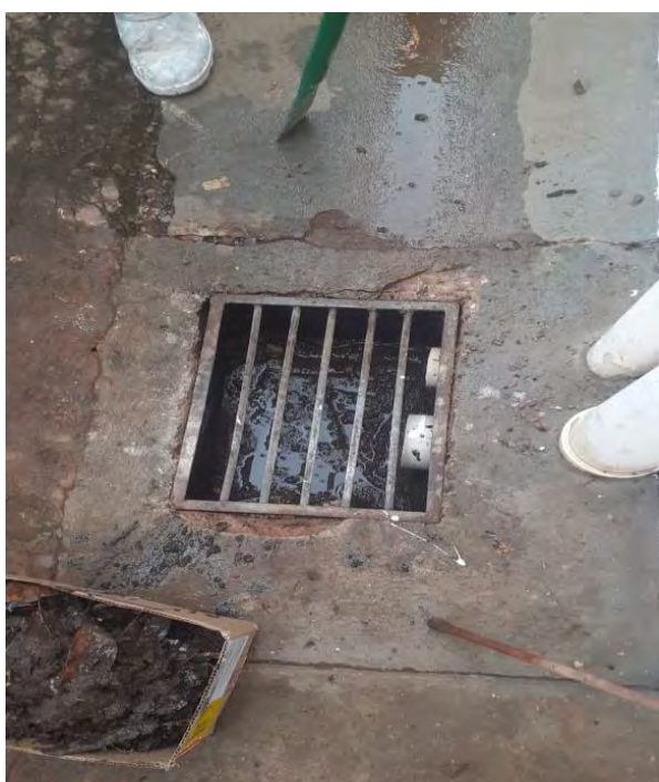
Limpeza dos sistema de drenagem pluvial da unidade.
