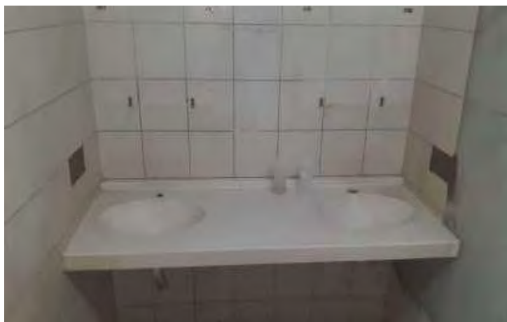
Azulejos e pia antes da reforma
