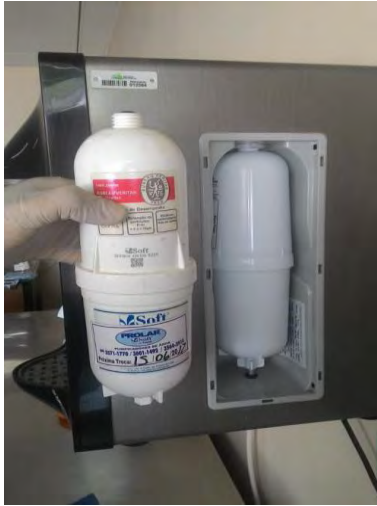
Foto. Troca do filtro do refeitório, filtro velho do bebedouro da administração e filtro novo respectivamente
