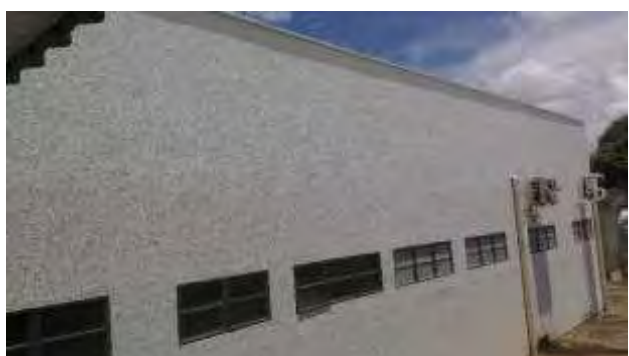
Parede parte de trás dos laboratórios pintada
