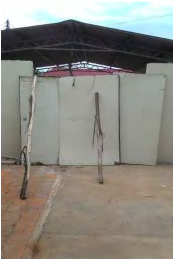
Madeiras escoradas na entrada da usina O 2 instalado
