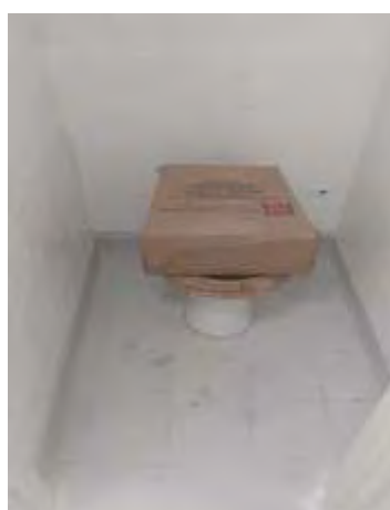
Vaso novos sendo instalados
