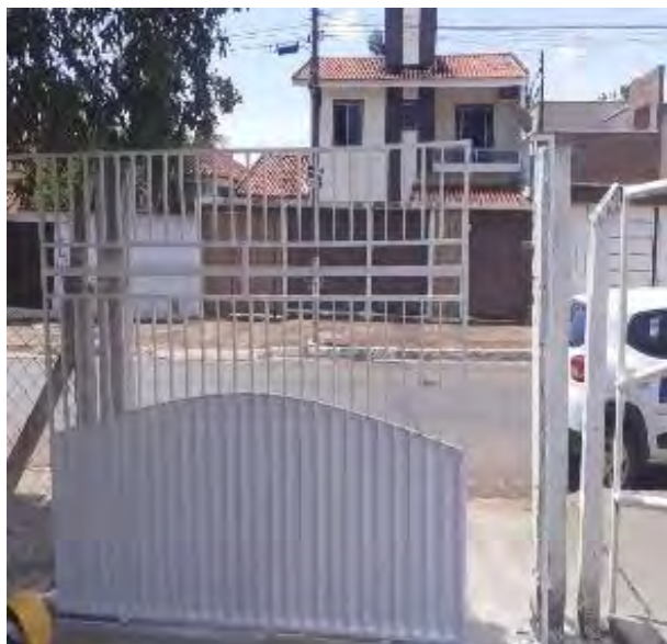
Figura: Troca e pintura do portão do estacionamento administrativo (antes).
