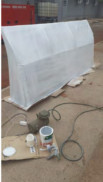
Pintura da estrutura de cobertura
