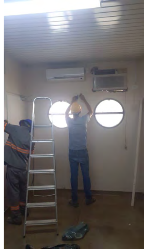
Paredes sendo lixadas para pintura
