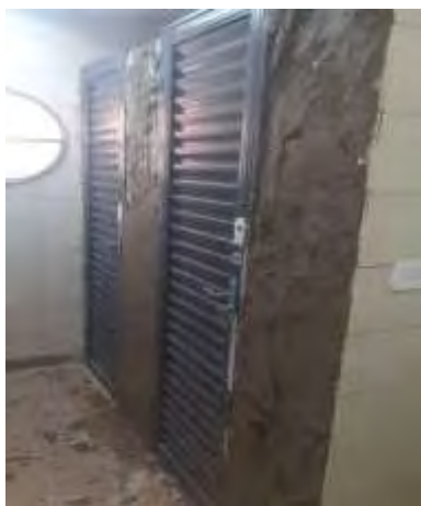
Paredes sendo rebocadas
