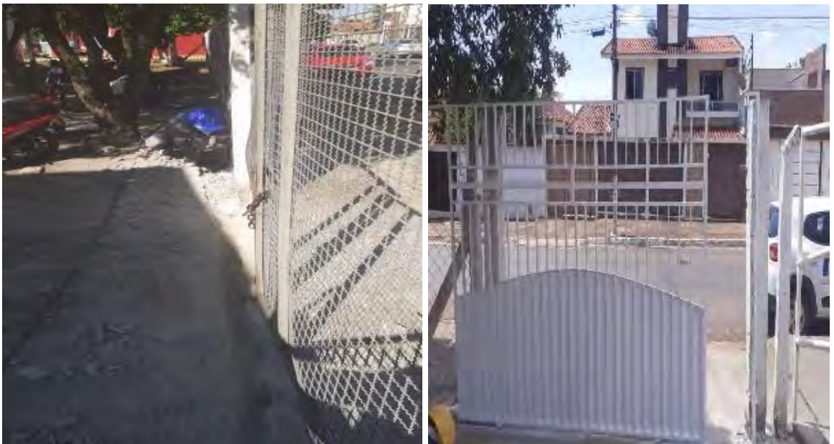
Troca e pintura do portão do estacionamento administrativo.
